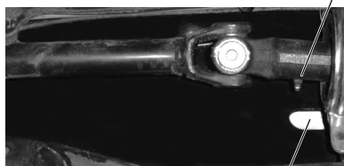
Доступ к штуцеру (вид сверху при снятой центральной панели)
